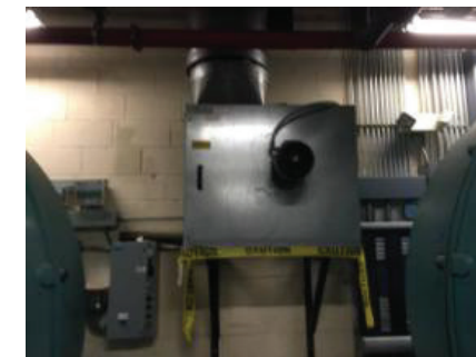
Combustion Air Fan
